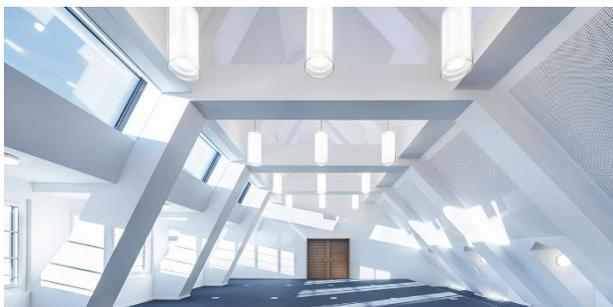
*Dans la salle de réunion à l'aspect sacré sous les combles, des cassettes en plaques perforées entre les poutres en béton assurent une bonne acoustique de salle. Le pignon lui-même est conçu au moyen d'éléments courbés préfabriqués.*
